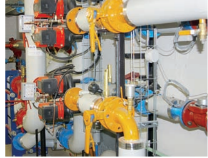
Réseaux de chaleur et d'énergie
