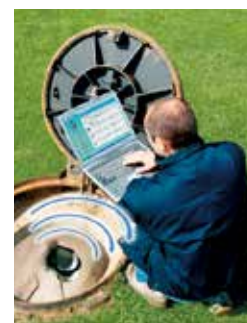
Assistance à la mise en service
